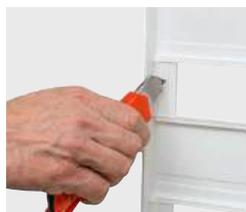
Die Haube hat in der Haubenwand Vorprägungen für Leitungseinführungen bzw. Kabelkanal-Anschluss
