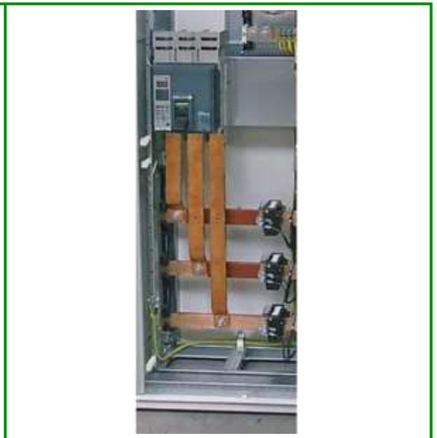
Systemlösung 185 mm Sammelschiene bis 630-1000 A für Schneider Leistungsschalter (NS)
