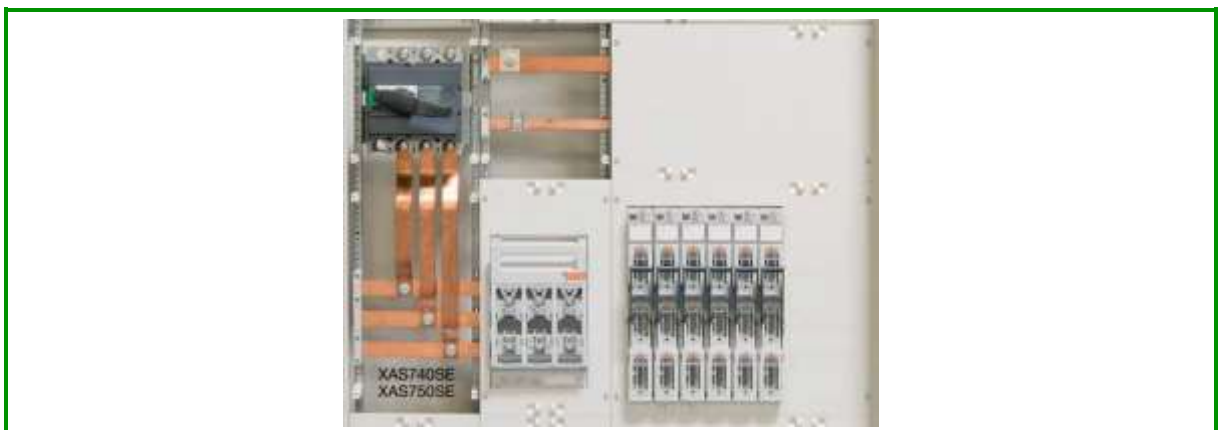
Beispiel mit Lasttrennschalter (INS).
