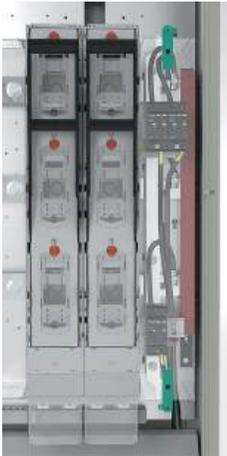
Mit der innovativen Lösung zur Montage einer Überspannungsschutzlösung direkt auf der 185 mm Sammelschiene wird der verfügbare Raum in der Anlage optimal genutzt.
