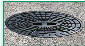
Der verschlossene Elektrant im Boden.
